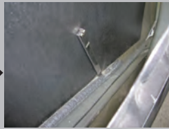
パネル裏面のシール剤をカットします
